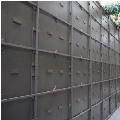
壁にリブラで枠を取り付ける 壁面枠完成後、上にセルビュー網を取付
