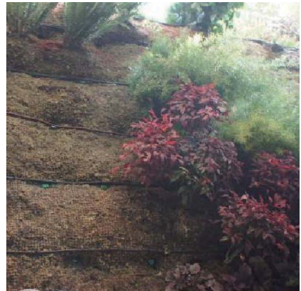
網の上にドリップチューブを 取付け網を切り、水苔の中に植栽
